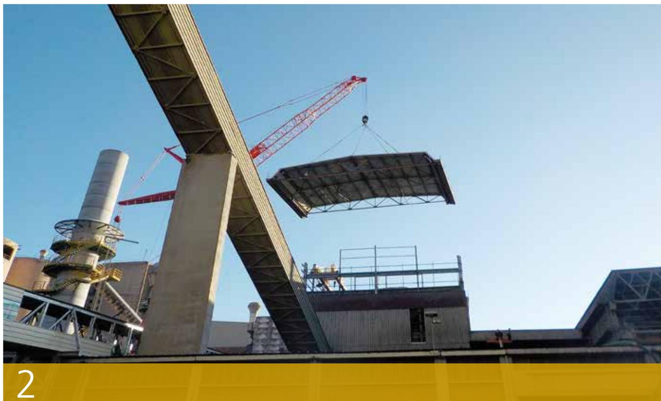
trasporto del nastro trasportatore esistente che riceve il cemento dall'impianto e lo trasporta ai silos di stoccaggio, si è deciso di progettare una nuova linea di trasporto, su canaletta, con elevatore a tazze per il sollevamento del materiale ai silos.
